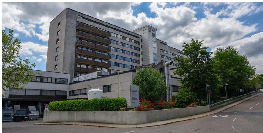
Das Krankenhaus Holweide Foto: Uwe Weiser
